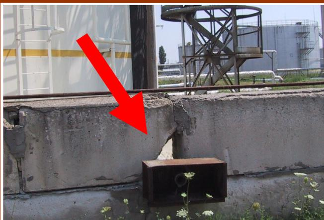
箭頭標示防溢堤上的一個破洞。在堤牆的底部和頂部，可以看到更多的損壞。
