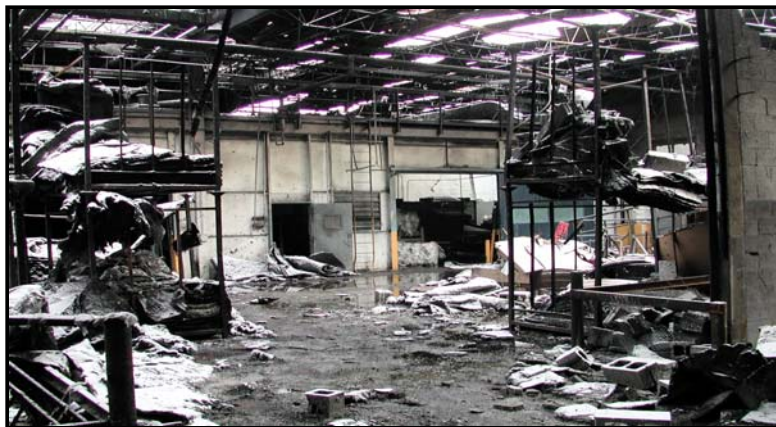
Photographie courtoisie du "The U. S. Chemical Safety and Hazard Investigation Board". Visitez leur site Internet à http://www.csb.gov for more information
