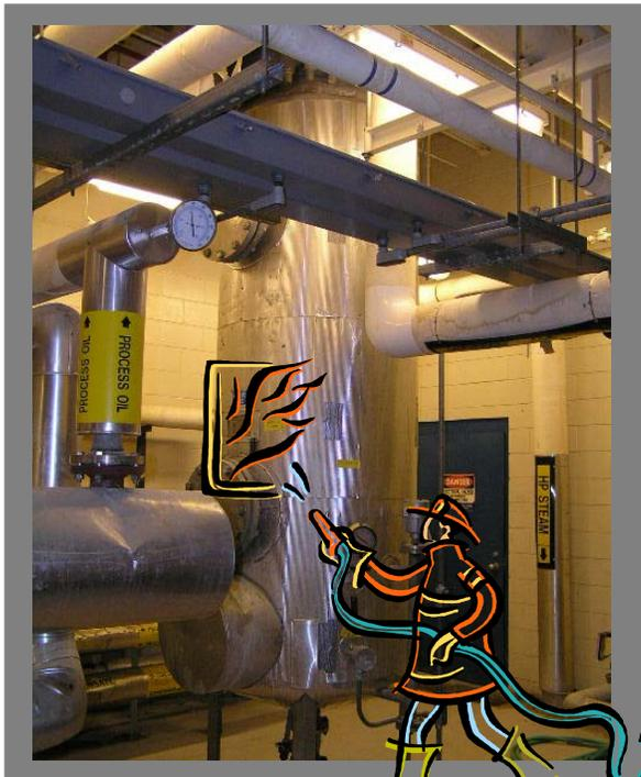
Esta stripper é usada para separar solvente leve de um óleo pesado. Anualmente a unidade é parada para limpeza interna e inspeção. A prática estabelecida é aguardar 24 horas antes de abrir a torre e começar o trabalho de manutenção.
