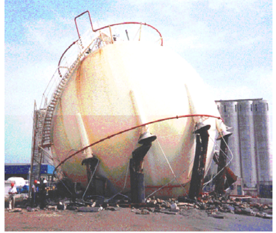
支撑结构被侵蚀
