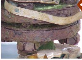
الوصلة بالجهة اليسرى تعاني من التآكل بشكل شديد وكذلك الصواميل تعد بحالة سيئة للغاية لذلك فهناك احتمال للتسرب من هذه النقطة بأي لحظة. لحسن الحظ لم يكن هذا الوضع السيئ متواجداً خلال فترة التفتيش وتم استبدالها بوصلة جديدة كما هو مبين بالشكل بالجهة اليمنى.
