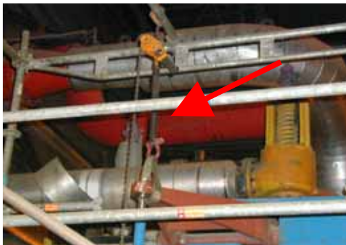
足場とスプリングとクランプで作った仮設パイプサポートの写真
