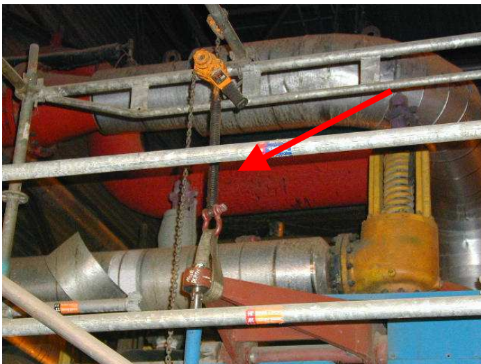
รูปข้างบนแสดงถึงการปรับปรุงตัวรองรับท่อที่ทำจากนั้สปริง (spring)และปากกักจับ(clamp)
