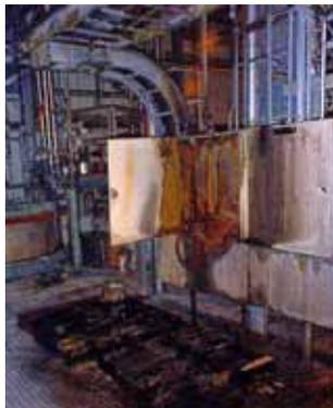
調査の結果、容器とその中の物質の相性が悪く、時間の経過に伴い化学薬品が、傷んだ容器や入れすぎた容器から、あるいは容器の外側のこぼれたものから漏出していた。この一部が開放格子床を通して床下のケーブルトレイに落下した。ケーブルトレイ中にこぼれた物質を見つけたり、取除いたりするのは困難であり、最終的にこぼれた物質が反応し、熱を持ち、燃え上がったことが明らかになった。
