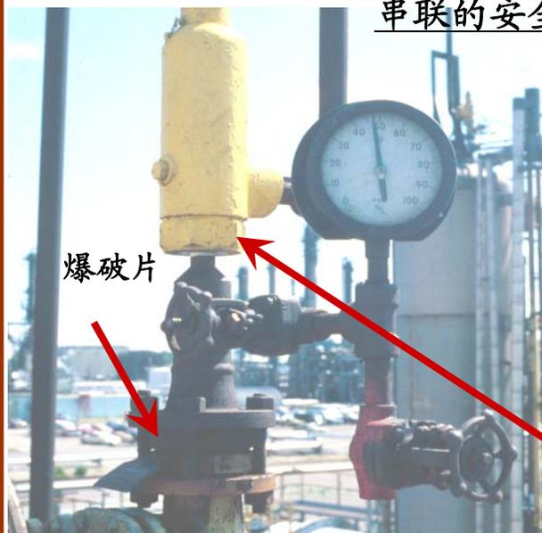
一个容器上有一个爆破片和一只安全阀，它们串在一起以防止容器内出现超压。在爆破片和安全阀之间的管道上安装有一只压力表。作为日常工厂检查的一部分，你会对压力表进行检查。这只压力表正常读数应为零。但今天你观察到压力表的读数接近3.5巴，如图示。
