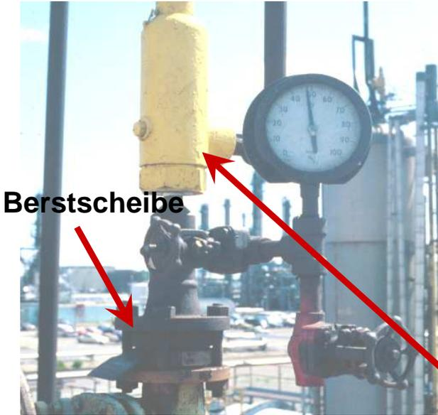
Ein Behälter ist über Berstscheibe und Sicherheitsventil -hintereinander geschaltet- gegen Überdruck abgesichert. Zwischen der Berstscheibe und dem Sicherheitsventil befindet sich ein Manometer. Das Manometer soll im Rahmen der regelmäßigen Anlagenrundgänge überprüft werden. Es soll normalerweise keinen Druck anzeigen. In diesem Fall (siehe Foto) zeigt das Manometer beinahe 50 psig (~3.5 barg) an.
