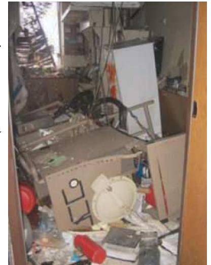
Danos no laboratório
