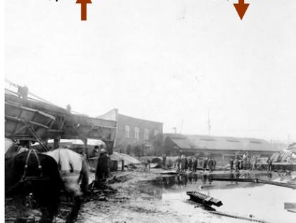
1919年1月15日，在马萨诸塞州的波士顿北部，人们听到了巨大的隆隆的声响，并恐怖地看见了15米高的装有8700立方米的蜜糖槽突然解体，蜜糖泄漏到城市里，糖浆的巨浪有5米高，50米宽，汹涌奔腾通过街道。糖浆洪流在1月份的天气里究竟以多快的速度在流动呢？这个洪流巨浪在通过两个多城市街区的时候，其移动速度估计在60公里/小时。21人因此死亡，150多人受伤，估计损失等同于现在的1亿美元的损失。
