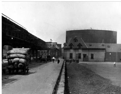
1919年1月15日、マサチューセッツ州ボストン市北部の人々は轟音を耳にするとともに、230万米ガロン(8700m<sup>3</sup>)の糖蜜を蓄えた高さ50フィート(15m)のタンクが突然分解し、内容物が市中に流れ込むという恐怖を目の当たりにした。糖蜜は、高さ15フィート(5 m)、幅160フィート(50 m)の大波となり街路を通り抜けた。1月だから糖蜜の動きは鈍いのではないと思うかもしれないが、この大波は推定時速35マイル(60 km/hr)で2街区以上を通過した。死者21名、負傷者150名以上、そして推定損害額は現通貨に換算して1億米ドルに相当する。
