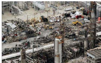
Marzo 2005, explosión en la refinería de petróleo Texas, Texas City
