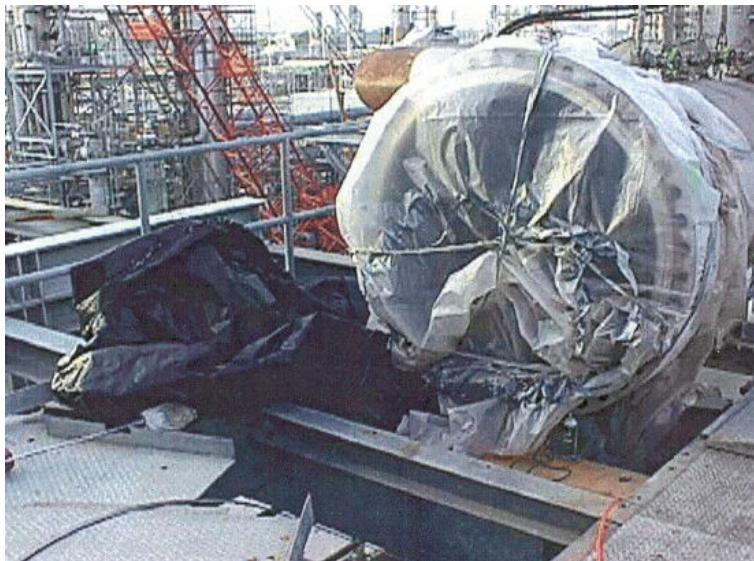
فکر میکنید با کشیدن پلاستیک سیاه بر روی انتهای خط لوله (مشابه تصویر) فضای سربستهٔ خطرناکی ایجاد می‌شود؟ بله این عمل میتواند فضای سرستهٔ خطرناکی ایجاد کند! دو کارگر برای جلوگیری از تابش نور خورشید و امکان انجام بازرگانی، از پلاستیک سیاه استفاده کردند. متاسفانه، ۱۵۰ فوت دورتر (۴۵ متر) چندین طبقه پائین تر از محل کار شیلنگ نیتروژن از طریق خط لوله یاد شده متصل شده بود. نیتروژن از بدلیل بسته بودن خط لوله یافته و در انتهای آن بدلیل بسته بودن خط لوله توسط پلاستیک سیاه میزان اکسیژن کاهش یافته
