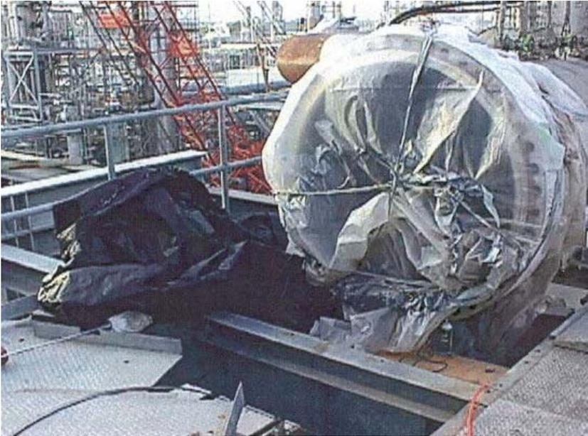
사진에서와 같이 개방된 배관 끝단을 검정비닐시트가 덮어서 위험한 밀폐공간을 만들 수 있다고 보십니까? 만들 수 있습니다, 위험한 밀폐공간이 생겼습니다! 두 명의 작업자는 배관 내부 검사를 위한 수은등(black light)을 사용할 수 있게 햇빛을 차단하고자 검정 비닐시트를 사용했습니다. 불행히도 약 46 미터 떨어진 몇 층 아래에 질소배관이 문제의 개방된 배관에 연결되어 있었습니다. 질소는 배관을 따라 개방된 배관 끝단으로 흘러 나오고 있었습니다. 배관 끝단을 덮고 있는 검정 비닐시트는 작업공간에
