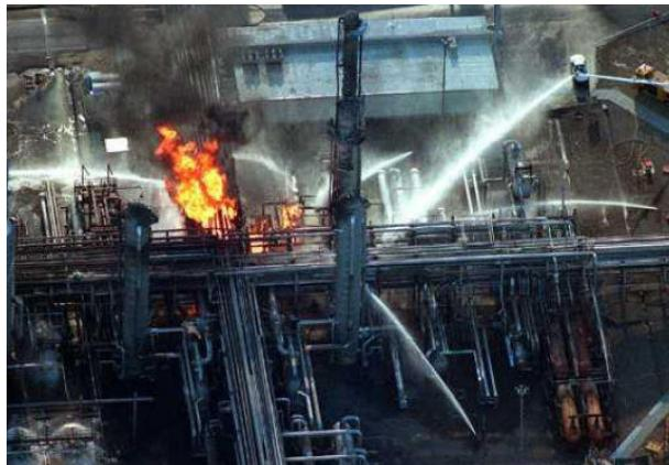
估計含有10公噸以上的易燃性瓦斯的蒸氣雲釋放出來，隨後被某加熱器所點燃。
