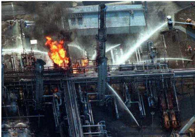
Der Wärmetauscher versagte durch Sprödebruch. Eine Wolke von über 10 to brennbarem Gas wurde freigesetzt. Sie zündete an einem Ofen. Bei der Explosion und dem Brand wurden zwei Mitarbeiter getötet und acht Mitarbeiter verletzt. Der Brand dauerte 2 Tage. Die Gasversorgung eines Teiles von Australien war für fast 3 Wochen unterbrochen. Nahezu 4 Millionen Menschen waren davon betroffen. Der wirtschaftliche Schaden betrug über 600 Millionen Euro.
