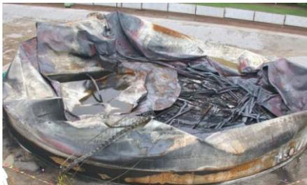
경유를 충전 중이던 8만 배럴(3.6 million gallon, 12,700 cu. M.)용량의 유류제품 저장 터미날의 floating roof 저장탱크에 폭발 화재가 발생했습니다. 사고 당시 탱크에는 약 7천배럴(300,000 gallons, 1,100 cu. M.)의 경유가 저장되어 있었고 이전에는 휘발유를 저장 하었다고 합니다. 불은 21시간 동안 타올랐고 인접한 2개의 저장 탱크에마저도 손상을 입혔습니다. 인명피해나 부상은 없었지만 손실이 총 미화 2백만달러 이상을 달했고 인근 주민들이 대피해야 했으며 지역의 학교도 이틀 동안 휴교 조치를 해야 했습니다.
