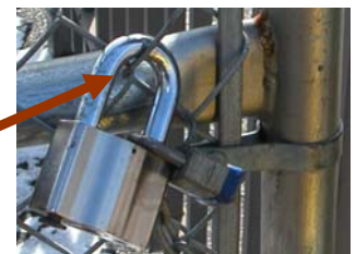
Motors langs die draad kan indringers help om oor te klim.
