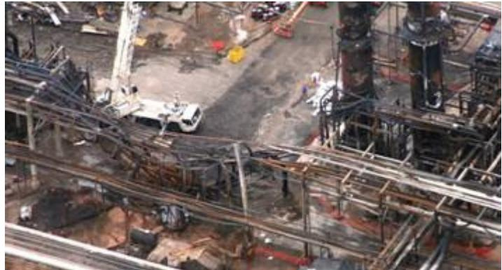
段不用的管道的低點。在冬季期間，聚積在此段不用的管道內的水結冰了。當水結冰時會膨脹，而膨脹造成此段不用的管道起裂縫。待天氣回溫，冰熔化了，而丙烷則從活管道經由關不密的隔離閥漏出來，然後經由已破裂的管道洩漏出到外面。一大朵易燃的蒸氣雲形成而又被點燃了。引起的火災造成四人受傷，煉油廠則須疏散，並且停爐了將近二個月。火災對其他設備和管道系統造成了重大傷害，進而造成更多易燃性物料的排放和火災的升級。超過二噸的毒氯氣也從受火災影響的容器內排放出來。
