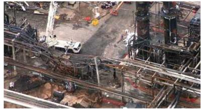
冬の間に使用していない配管中に蓄積した水が凍結した。 水は凍結時に膨張するので、この膨張により使用していない配管にクラックが発生した。 暖かくなって氷が溶け、生きている配管から漏れのある仕切バルブを通してプロパンが漏れだし、更にクラックの入った配管から外に流出した。 巨大な引火性の蒸気雲が形成され、着火した。 その結果発生した火災は4人の負傷者を出し、精油所は全面避難を余儀なくされ、2ヶ月近くの間全面閉鎖された。 火災は他の機器や配管に大きな損害を与え引火性物質を更に放出し、火勢を増大させた。 この火災の影響を受けて、2トン以上の塩素がコンテナーから放出された。
