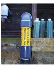
水硫化ソーダ溶液のトラックが午前3時半頃工場に到着し、右図の上部中央近くにある貯蔵タンクに荷降ろしすることになっていた。トラック運転手はこのプラントに来たことがなかったので、プラントのシフト責任者に指示を求めた。そのシフト責任者は化学品の受入れがあることを予め言われており、その化学品は、彼が自分のシフトで受入れたことのある唯一の化学品である硫酸第一鉄であろうと思い込んでしまい、トラック運転手に、図中の
