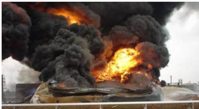
此一事件的調查發現：貯槽正在進料/加油，而操作人員並不知道貯槽液位計和高液位報警系統皆已故障失效了。操作人員並未密切監視此加油操作，因為他們相信貯槽仍然有足夠的容量。
