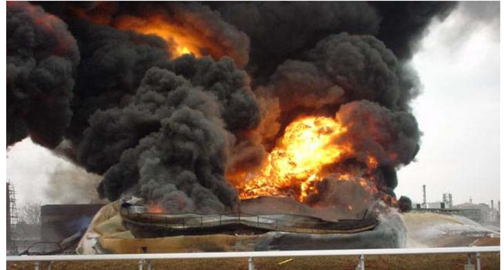
Plus d'une douzaine d'employés furent hospitalisés et il y eut des dommages importants à la propriété. L'enquête sur cet incident révéla que le réservoir était en remplissage et que, hors de connaissance des opérateurs, la jauge de mesure de niveau du réservoir ET l'alarme de haut niveau ne fonctionnaient pas. Les opérateurs ne surveillaient pas l'opération de remplissage de près car ils croyaient que le réservoir avait encore amplement de capacité.
