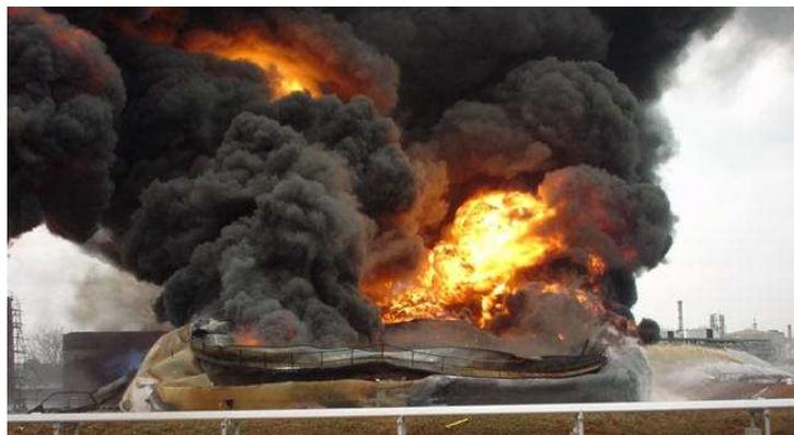
hospitalizados e houve danos materiais significativos. A investigação descobriu que o tanque estava recebendo produto e que, sem que os operadores soubessem, o indicador de nível do tanque e o alarme de nível alto falharam. Os operadores não monitoraram de perto a operação de recebimento (enchimento) porque eles acreditavam que ainda existia bastante espaço no tanque.
