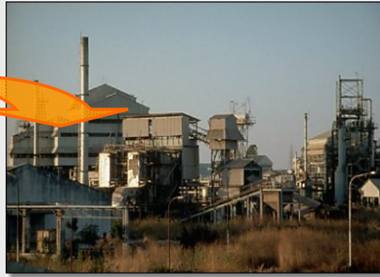
Impianto di Bhopal della Union Carbide
