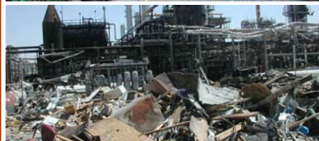
Destruição causada pela explosão de uma Refinaria de Texas City a 23 de Março de 2005.
