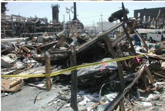
Skade aan tydelike geboue en karavane na die Maart 2005 Texas City ontploffing.
