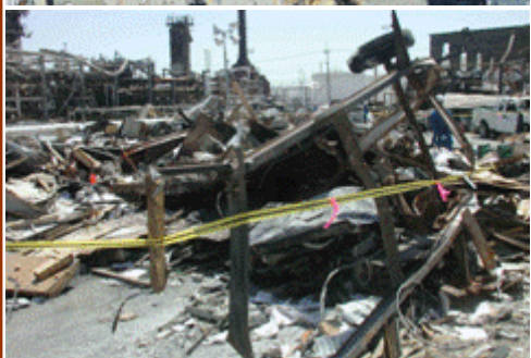
2005年3月德克薩斯市爆炸 對可移式拖車屋群所造成的損害
