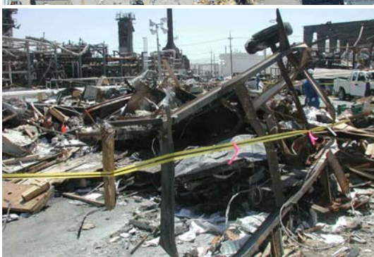
Schade aan werkketen als gevolg van de explosie in Texas City in 2005
