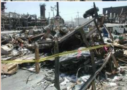
Kerosakan pada treler (porta-cabin) akibat letupan di Loji Penapisan Texas City
