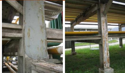
بعض الأمثلة للتلف الذي قد يصيب المواد المقاومة للحريق التي تحمي دعامات جسر أنابيب معدني، بسبب إزالة المادة الواقية أو تقادمها واهترائها ←
