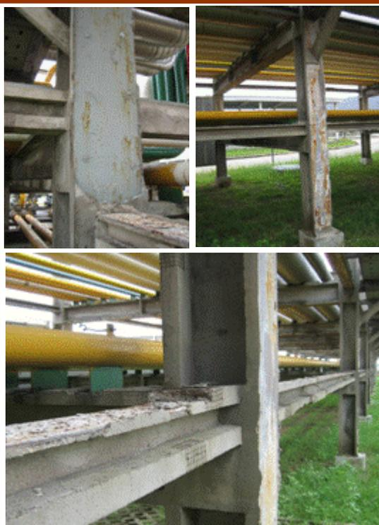
← 管橋鋼架表面之防火材(被覆)受損的例子 - 其防火材(被覆)已被除去或已劣化而掉落。
