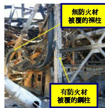
2010年4月號「製程安全明燈(Beacon)」討論使用防火(耐火)裝置以保護製程管道之元件，特別是「長螺栓無法蘭的閘門」。防火材是一種耐火的絕熱材料，也經常施加於結構鋼材之表面，可使鋼材在陷於火海時能延緩升溫。主要目的是提高結構鋼維持其完整性的能力，一直到火災被撲滅或著其他主動性消防系統能提供足夠的冷卻保護作用。若無防火材被覆，陷於火海的結構鋼，像是在左上圖中的管架支柱，或在右上圖中的支柱，可能在幾分鐘內，就會很快喪失強度而失去支撐效用。管道與設備支架的失效會折斷管道，或導致製程容器失效(fail)，而洩漏出更易燃的物質，並引起較大的火災。
