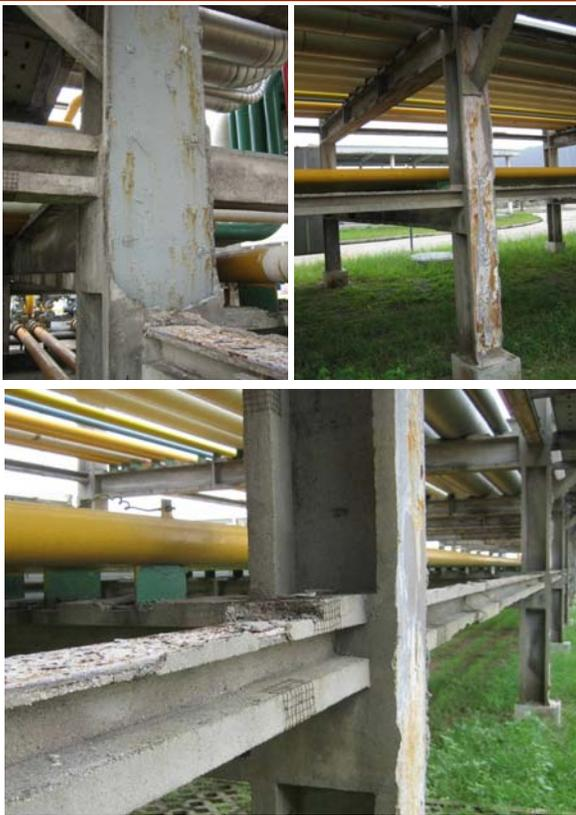
← Einige Beispiel von beschädigten Brandschutzbeschichtungen auf Stahlstrukturen– die Beschichtung wurde entweder entfernt oder beschädigt.
