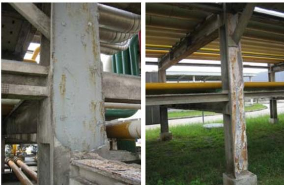
← Alcuni esempi di danni a protezioni antincendio su supporti in acciaio di rack – la protezione è stata rimossa o si è degradata e si è staccata.
