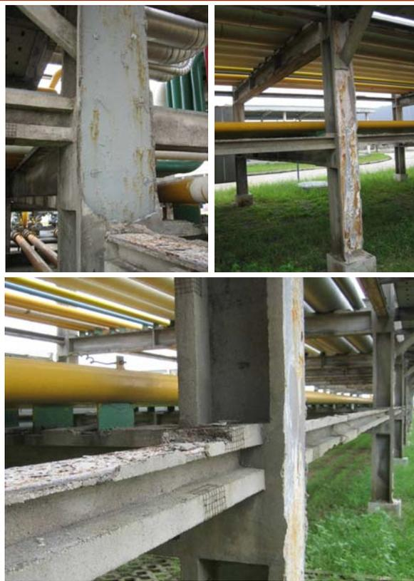
← Несколько примеров разрушений огнезащиты колонн для поддержки моста из стальных труб - огнезащита либо была удалена, либо так серьезно разрушилась, что почти совсем исчезла.
