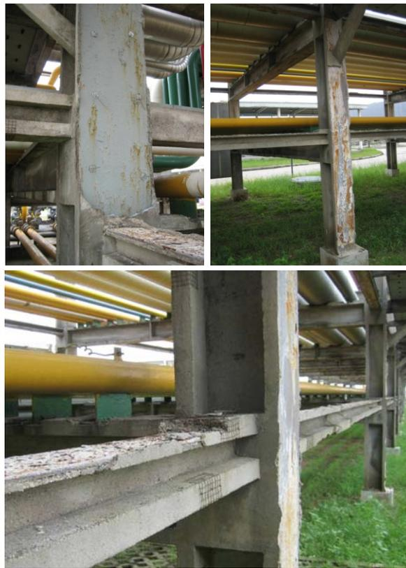
← Ejemplos de daño a protección contra fuego en soportes de acero de puentes de cañerías – la protección ha sido removida, o se ha degradado y ha caído.
