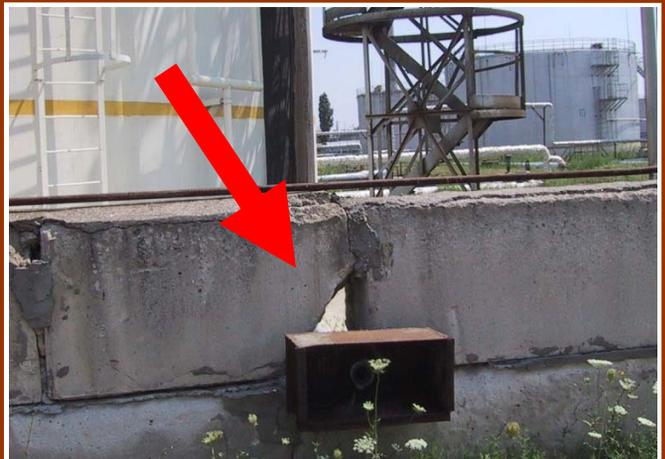
图中箭头所指是围堰上的一个洞。我们可以在围堰底部和上部看到更多的损坏的地方。其它损坏的例子包括围堰墙面和地面上有裂缝，管道安装穿过围堰墙留下的孔洞以及其它使溢出的材料流出围堰区域的情况。
