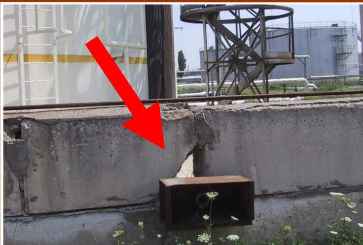
A seta mostra um buraco num dique de contenção. Mais danos podem ser vistos na base e na parte superior da parede do dique. Outros exemplos de danos incluem fissuras em paredes ou fundo de diques, buracos criados para permitir a passagem de tubulações através de paredes dos diques e outros tipos de danos que poderiam resultar em vazamentos para fora da área do dique de contenção.
