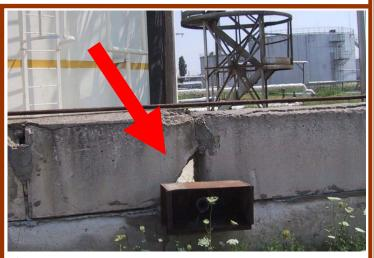
Стрелка показывает на отверстие в защитном ограждении. Видны также другие разрушения защитной стенки у ее основания и наверху. Другие не видимые примеры разрушений защитной стенки включают трещины, дырки от ранее проложенных труб и т.п. Все это может способствовать утечке разлившегося материала через защитное ограждение.
