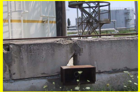
Juin – ouverture dans le muret d'une cuvette de rétention d'un parc de réservoirs
