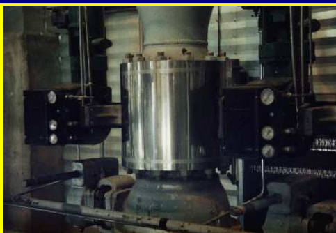
Απρίλιος – Μόνωση επιφάνειας βάνας με μακριές βίδες χωρίς φλάντζα
