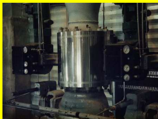
Abril – Cobertura isolante em uma válvula sem flanges com parafusos longos
