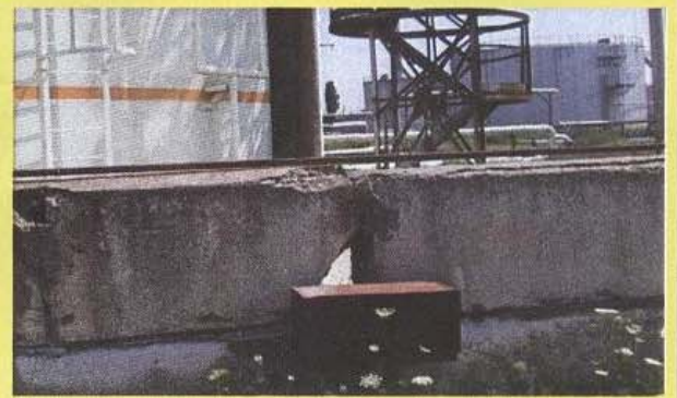
జూన్ నెలలో కర్మాగారాలలో ట్యాంక్ల క్రింద భాగంలో నిర్మించే రక్షణ తొట్టెలు మరియు చక్రాలపై ఏర్పరిచే రక్షణ బిత్తు నిర్మాణాలు
