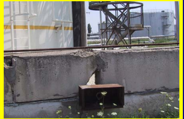
มิถุนายน - รูที่กำแพงกันของเหลว สำหรับถังเก็บของเหลว
