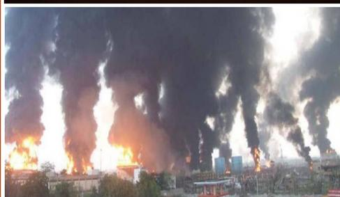
蒸氣雲爆炸發生於大量的易燃或可燃性物質釋放（洩漏）出來，與空氣混合，而後被引燃。蒸氣或氣態燃料釋放的一些原因有：
