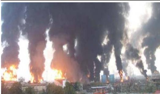
Eine Gaswolken-Explosion entsteht, wenn genügend entzündbares Material freigesetzt wird, sich mit der Luft mischt und dann zündet. Einige Ursachen für die Freisetzung dampf- oder gasförmiger Stoffe:
