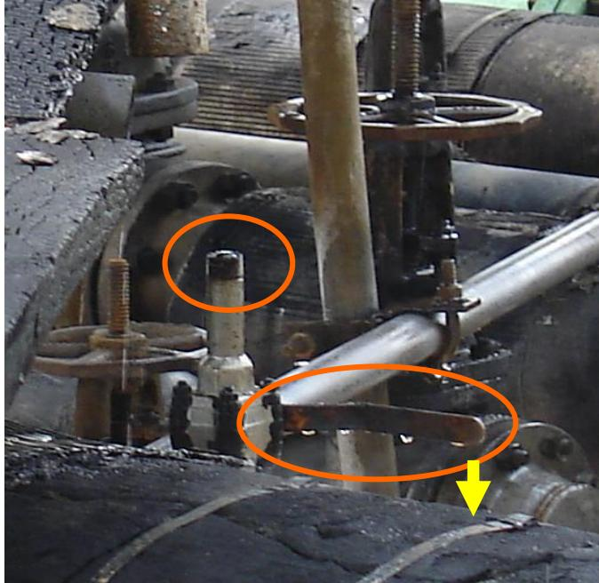
قطعه ای از روی یک داربست موقت به پائین سقوط می کند. یک والو ۳/۴ اینچی (نقریباً ۲۰ میلی متری) بر روی خط لوله فرایند به عنوان مسیر تخلیه اضطراری نصب شده بود. این قطعه دقیقاً بر روی دسته والو که بصورت افقی بوده سقوط کرده و یک چهارم والو را باز می کند. خط لوله محتوى مواد قابل اشتعال بوده که از طریق این ونت به محیط تخلیه می شود. مواد تخلیه شده آتش گرفته و سبب مرگ یک نفر پیمانکار و سوختگی دونفر دیگر می شود.
