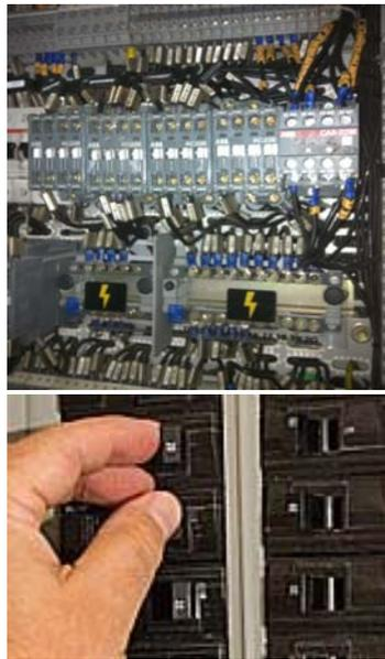
一名维修人员到电气间去切断一个非工艺设备的控制回路的电源。然而，他却误把工厂里可编程逻辑控制器（PLC）的电源给关闭了。当他意识到自己的错误后，随即恢复了可编程逻辑控制器的电源，然后才关闭了原计划停电的那只断路器。然而，可编程逻辑控制器电源的暂时中断造成部分工艺设备停止运行，而另一些在继续运转。这样工艺运行被打乱了，此时它只有部分控制功能在起作用，隔断阀因此被关闭，大量有毒材料通过超出其处理能力的排放洗涤塔而释放出来。幸运的是，没有人员受伤，泄漏出来的材料也没有超出工厂的范围。
